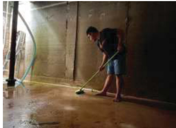
ล้างทำความสะอาดถังเก็บน้ำสำรองน้ำใช้
