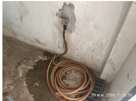
ก๊อกน้ำสำหรับใช้น้ำเสียที่ผ่านการบำบัดแล้ว
